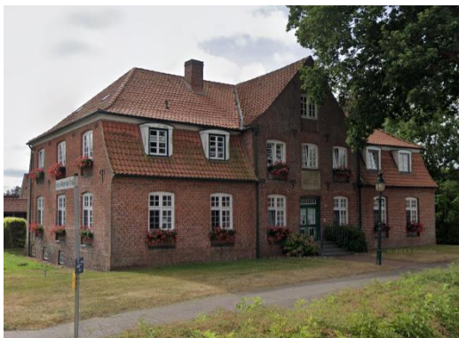
Stader Straße 24, Baudenkmal
