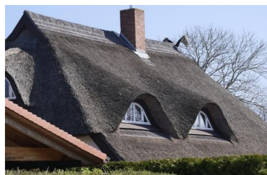
Abb. 08 Reetdach mit saniertem Schornsteinkopf Klinker
