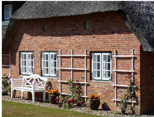
Abb. 10: Reetdach mit Traufüberstand
