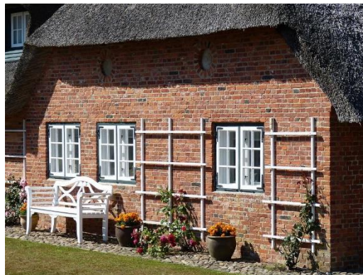
Abb. 10: Reetdach mit Traufüberstand
