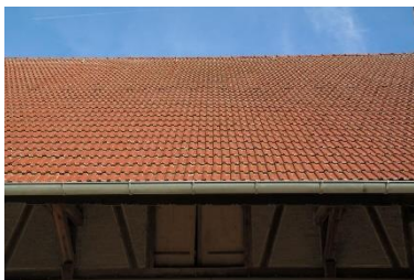
Dach mit naturroten Krempziegeln
